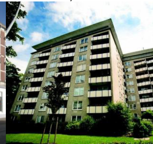
#32 | Berliner Str. 7 | Baujahr 1960 Rechnerischer Heizwärmebedarf: 190 kWh/m 2 a Tatsächlicher Heizwärmebedarf: 200 kWh/m 2 a
