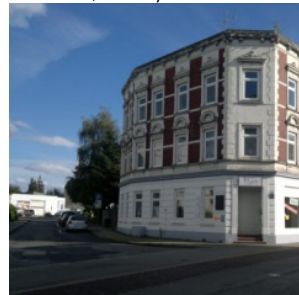
#9 | Vormstegen 25 | Baujahr 1910 Rechnerischer Heizwärmebedarf: 275 kWh/m 2 a Tatsächlicher Heizwärmebedarf: 306,6 kWh/m 2 a
