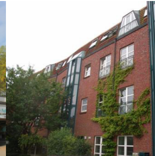
#15 | Osterfeld 2a | Baujahr 1980 Rechnerischer Heizwärmebedarf: 170 kWh/m 2 a Tatsächlicher Heizwärmebedarf: 167 kWh/m 2 a
