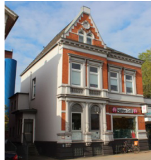
#1 | Vormstegen 16 | Baujahr 1900 Rechnerischer Heizwärmebedarf: 200 kWh/m 2 a Tatsächlicher Heizwärmebedarf: 202,3 kWh/m 2 a
