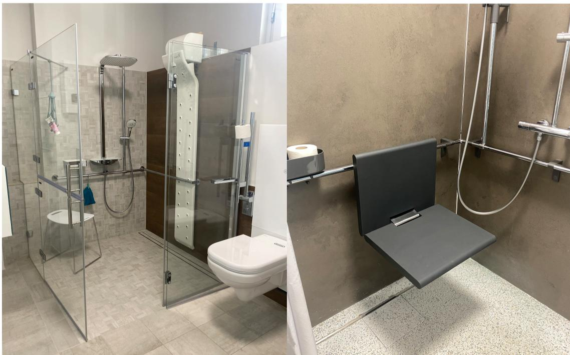
Abb. 07: Stufen- und schwellenlos befahrbare Dusche (links) und Dusche mit Klappsitz und Haltegriffe (rechts) (Eigene Aufnahmen)
