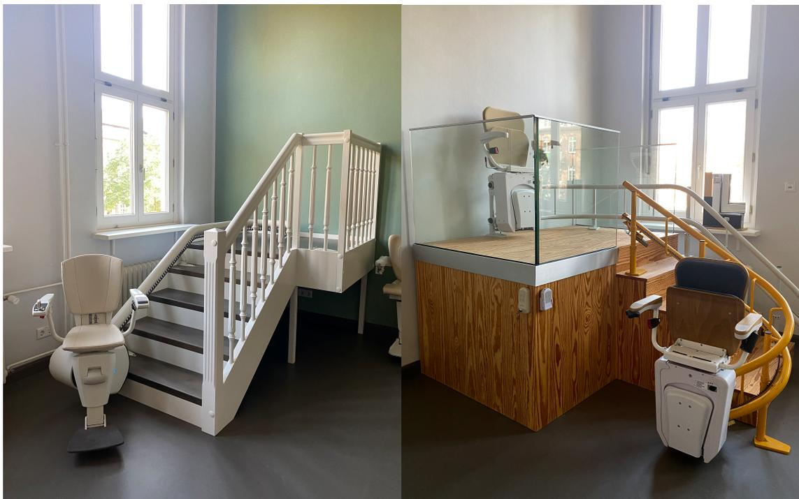
Abb. 06: Treppenlift im geradläufigem Treppenlauf (links) und Treppenlift im viertelgewandeltem Treppenlauf (rechts) (Eigene Aufnahmen)
