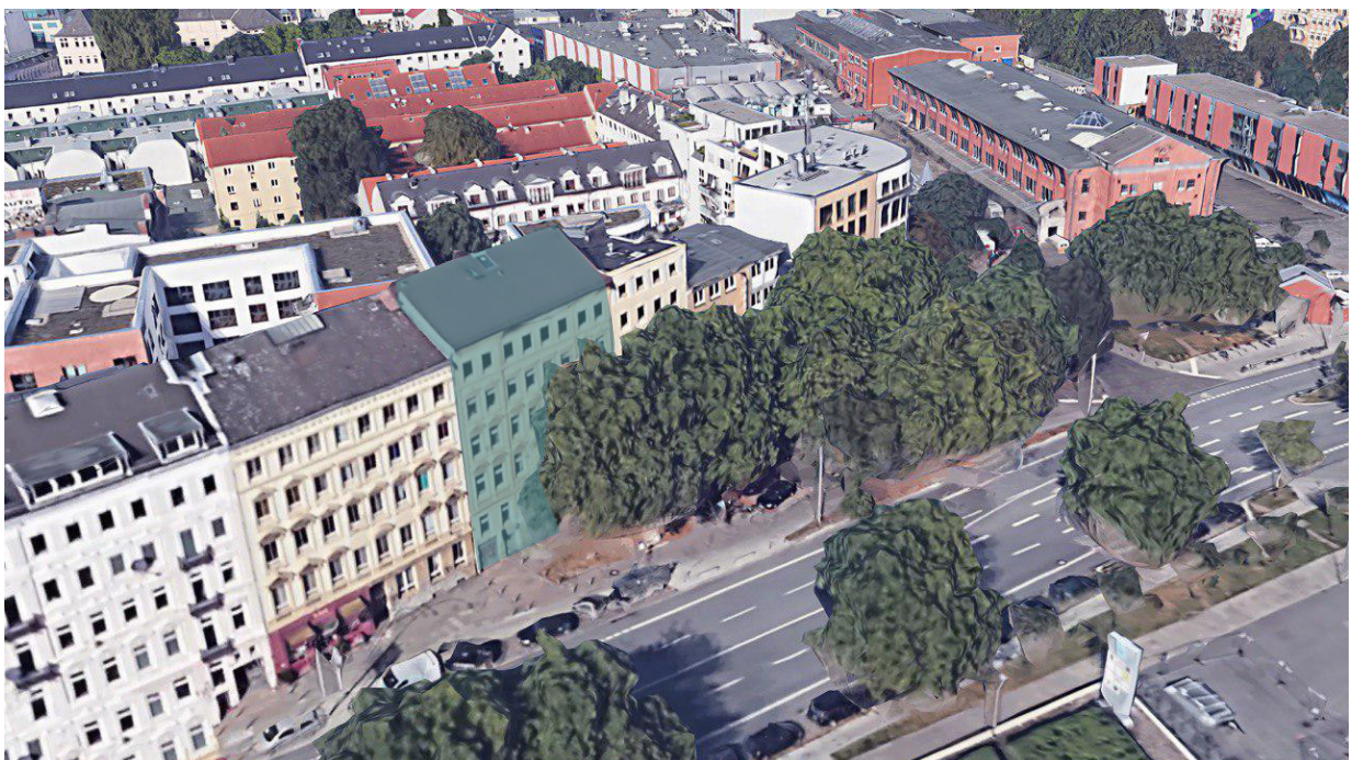
Straßenansicht Neuer Kamp 17
