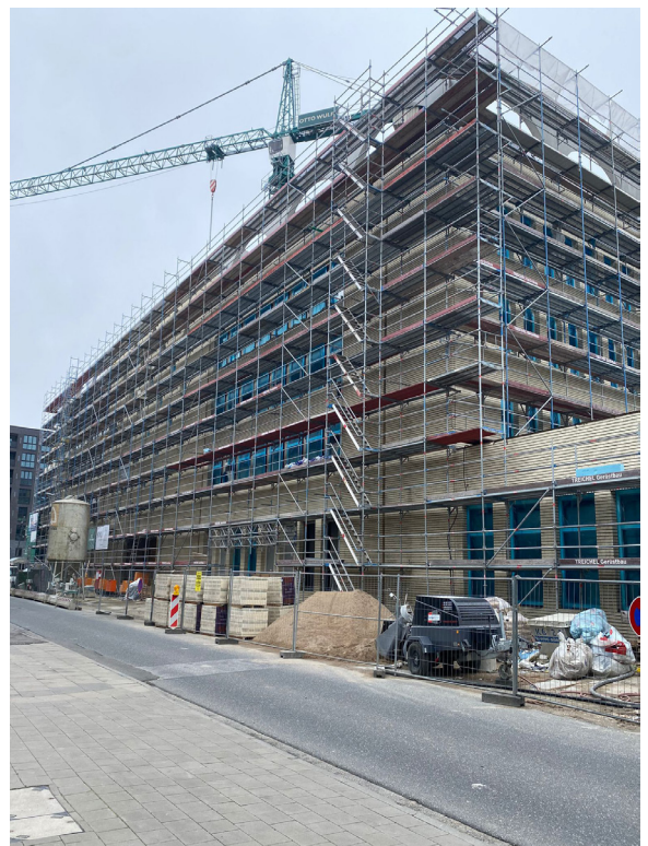
Abb. 14 Baustelle Grundschule Baakenallee. Eigenes Bild, 2023.
