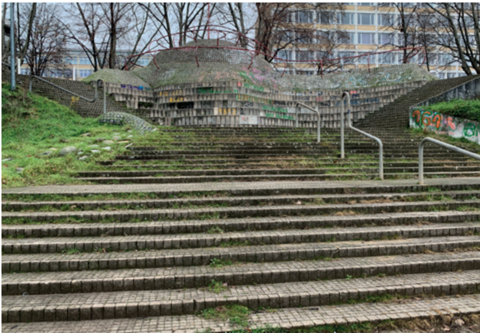
Abb. 28: Stufenanlagen am Collini-Areal
