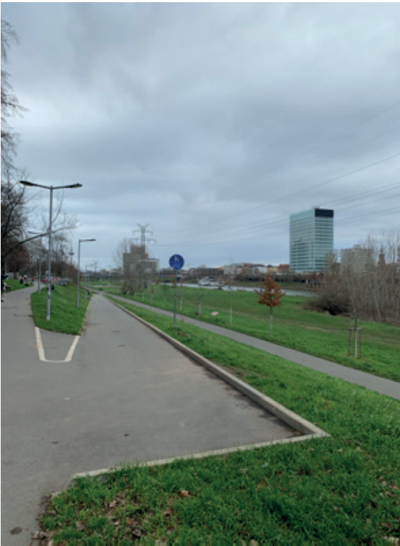
Abb. 29: Barrierefreie Rampe und befestigte Wege am Dammfuß und auf der Dammkrone
