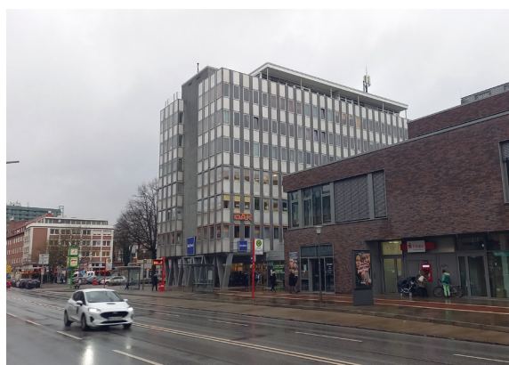
Abb. 2.7: Büroimmobilie Bestand Eigene Aufnahme
