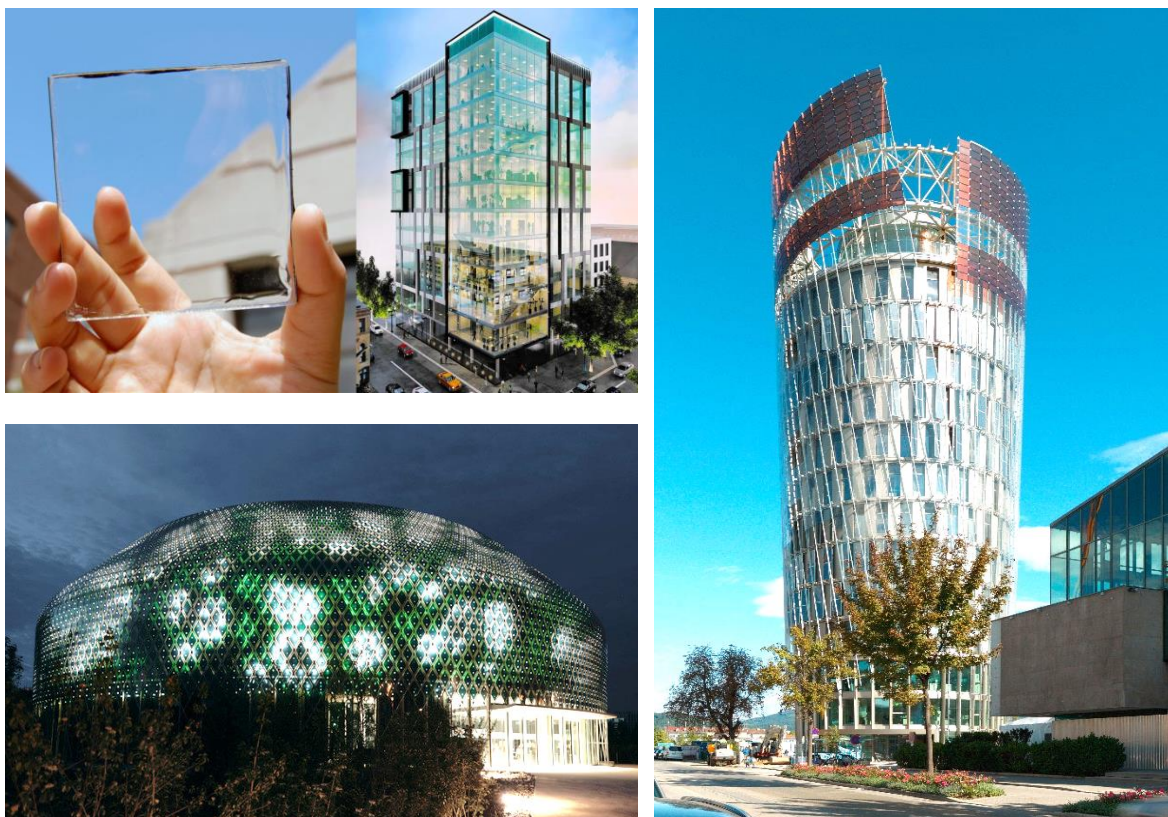
Abb. 154: Die Zukunft der BIPV: von völliger Unsichtbarkeit wie Salzmolekül-Zellen es ermöglichen könnten (o. I.: Goriber Tech), über die Demonstration neuester OPV-Zelltechnik am Science Tower, Graz (rechts: Markus Pernthaler Architekten) bis hin zur Inszenierung digitaler Dynamik am Novartis Konferenzzentrum in Basel (u. I.: Semiconductor/Laurits Jensen)
