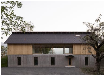
Abb. 11.11: Ansicht nördliche Dachfläche
