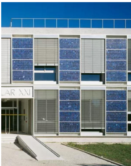
Abb. 3.8: Detailsicht der Südfassade
