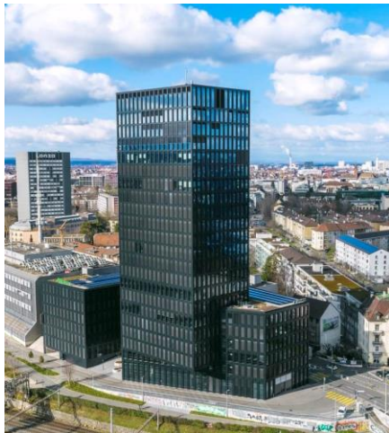
Abb. 12.5: Ansicht aus Südost
