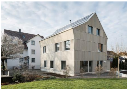
Abb. 8.9: Ansicht von Nordost
