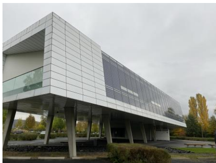
Abb. 5.15: Materialmix am Gebäude
