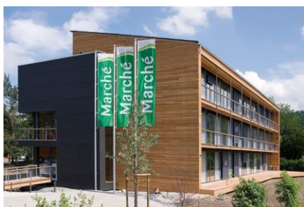
Abb. 1.5: Ansicht von Westen
