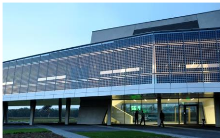
Abb. 5.16: Hervortretende Semitransparenz der Fassadenanlage am Abend bei innerer Beleuchtung
