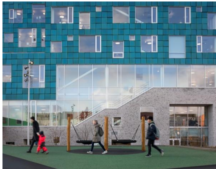
Abb. 10.10: Ansicht Fassade mit Personen
