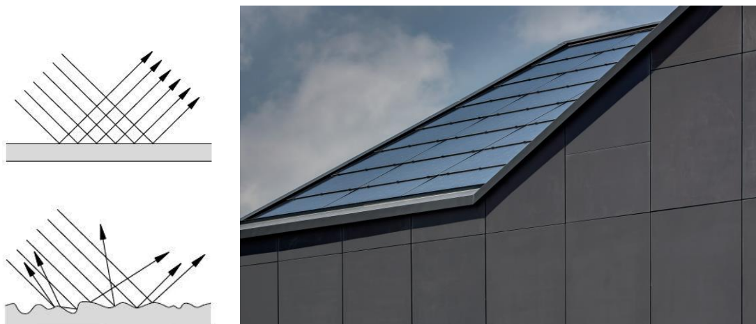
Abb. 86: Durch Sandstrahlen der Deckgläser matt erscheinende Dünnschichtmodule an der Fassade eines Mehrfamilienhauses in Brütten (links: Weller et al. 2009, S. 43; rechts: Umweltarena)
