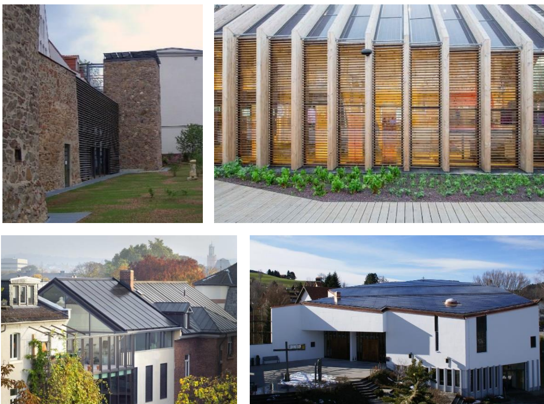
Abb. 95: Projektbeispiele mit einer dezent-unauffällig integrierten PV-Anlage, die sich angepasst und zurückhaltend in das Gebäude und die Umgebung einfügt (v. o. l. n. u. r.): Ev. Akademie, Meißen (Pfau Architekten); Belgien-Pavillon der Expo 2015 (Abitare/AGC Glass); opusHouse, Darmstadt (SeV 2009, S. 6); Katholische Kirche, Heiden (SeV 2019, S. 34)
