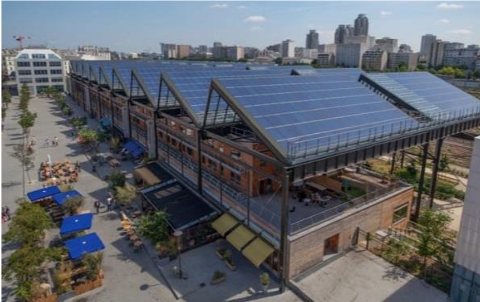
Abb. 69: Halle Pajol, Paris: Eine vorhandene Stahlkonstruktion, belegt mit PV, dient als Witterungsschutz und Energiedach für ein Quartier aus Holzbauten (Legendre)
