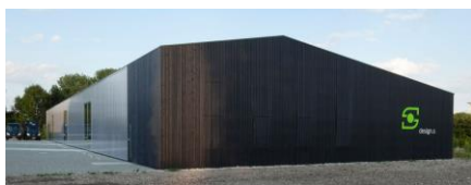
Abb. 4.13: Die hellere Nordfassade
