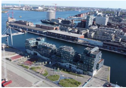
Abb. 10.16: Luftaufnahme aus Norden
