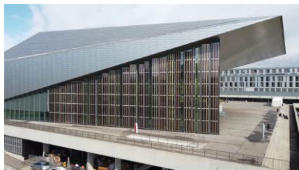
Abb. 7.13: Materialien am Gebäude
