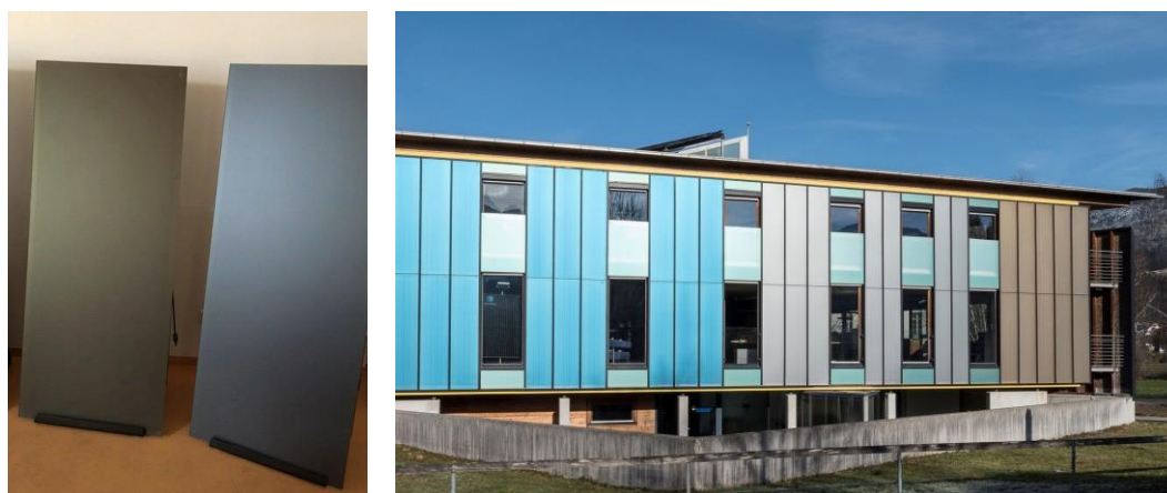
Abb. 80: Farbige Module mit an der EPFL entwickelten Farbfiltern für Solargläser am Hauptsitz von Doma Solartechnik in Satteins (AT) (links: Electrek; rechts: Swissinso)
