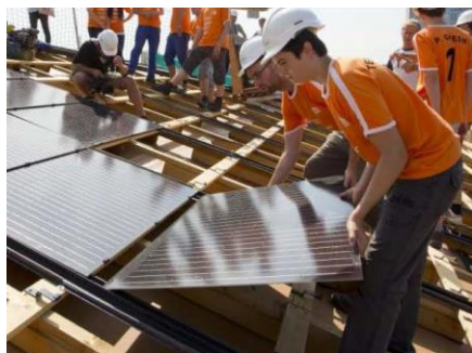
Abb. 6.18: Installation der Module
