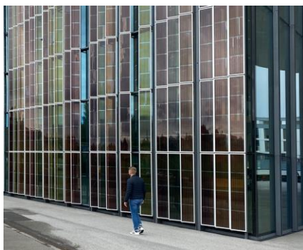
Abb. 7.10: Ansicht der PV-Anlage mit einem Passanten
