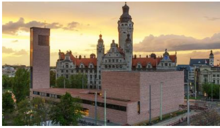
Abb. 13.11: Ansicht aus Südost
