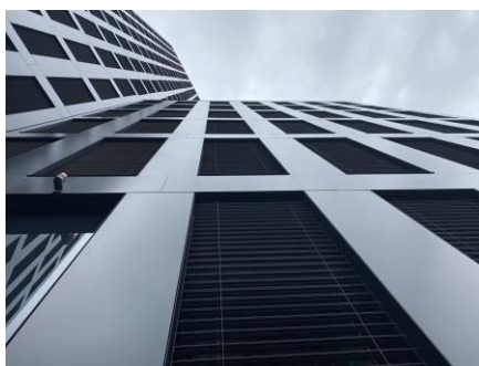
Abb. 12.7: Detailansicht Flächenbündigkeit Fassade
