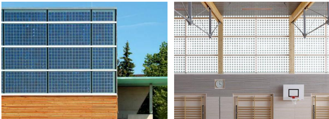
Abb. 70: Fassadenintegrierte PV-Module mit Isolierglasaufbau der Turnhalle Burgweinting in Regensburg bieten u. a. Wärmeschutz (links: Stadt Regensburg/DBU, rechts: Baunetz Wissen)
