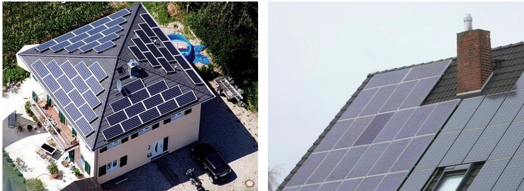
Abb. 97: Unregelmäßige Flächengeometrien und Durchdringungen als Herausforderung bei der geometrischen Abstimmung zwischen PV-Anlage und Gebäude (links: Kompetenzhaus; rechts: Westdeutsche Zeitung/Dirk Jochmann)
