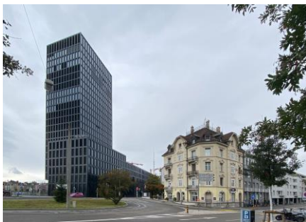
Abb. 12.16: Nachbarbebauung, Blick aus Osten
