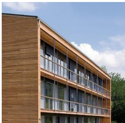
Abb. 1.9: Detailansicht Farben Holzfasade und Südfassade
