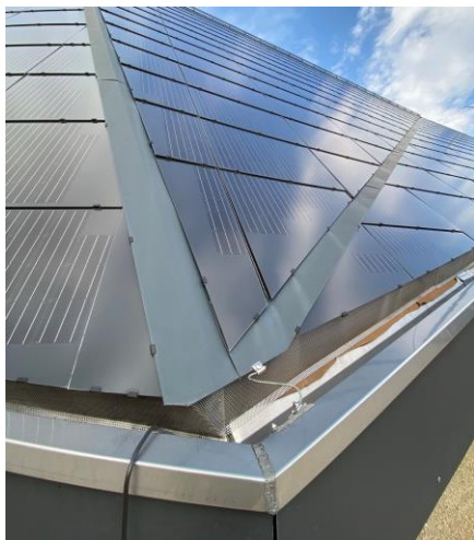
Abb. 6.7: Detailansicht Flächenbündigkeit und sonderangerfertigte Module
