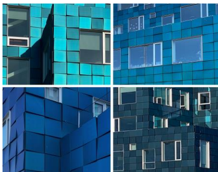
Abb. 10.12: Changierende Farbigeit der BIPV
