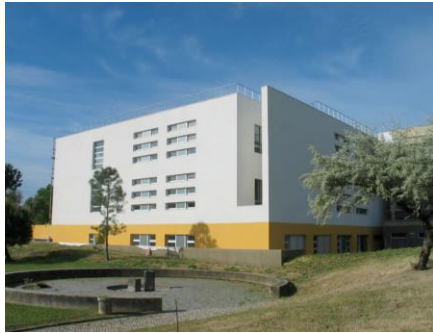
Abb. 3.9: Nord- und Ostfassade
