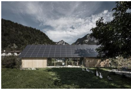
Abb. 11.10: Ansicht südliche Dachfläche
