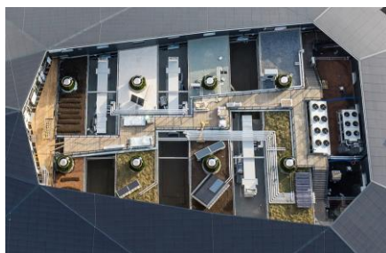
Abb. 6.19: Aufsicht Technikbereich Dach
