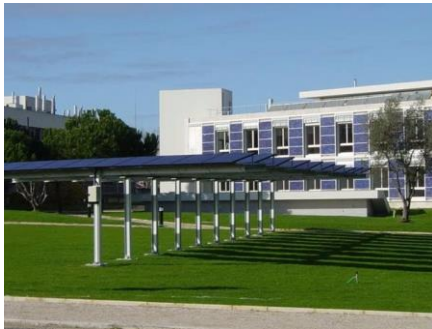
Abb. 3.14: PV-Parkplatzüberdachung vor dem Gebäude
