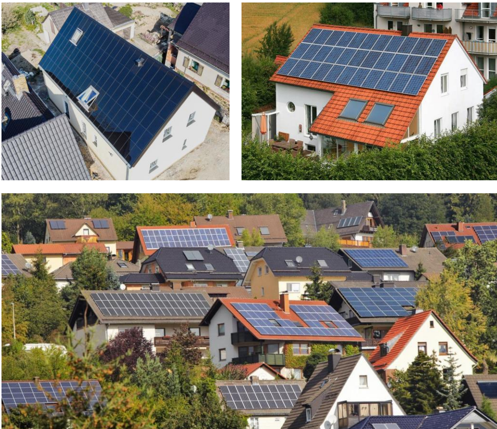
Abb. 102: Maßstäblichkeit eines großformatigen PV-Dachs im Vergleich zu benachbarten Dachdeckungen (o. l.: Heinze/Ennogie), im Vergleich zu anderen Elementen wie Dachfenstern (o. l.: enerix) und im Kontext einer Wohnsiedlung (unten: Geo/Ingo Bartussek)
