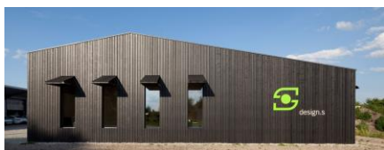
Abb. 4.7: Ansicht von Westen
