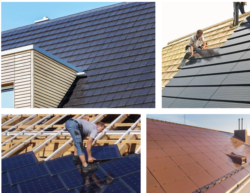
Abb. 82: Solaraktive Dachziegel und Schindeln verfügbar in unterschiedlichsten Formen von verschiedenen Herstellern (v. o. l. n. u. r.: Autarq; Nelskamp; SunStyle; 3S Solar Plus)
