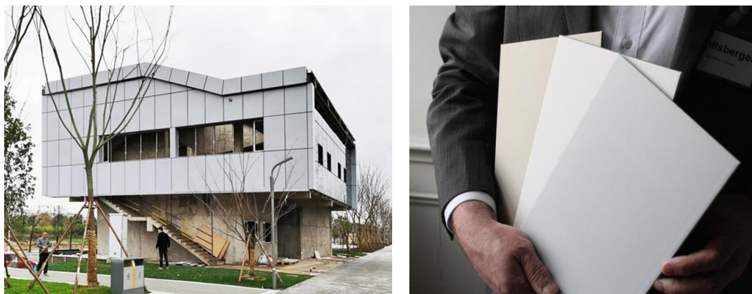
Abb. 79: Weiße Module an einem Gebäude in Quzhou im Osten Chinas (links: Solaxess, rechts: Solarwende Berlin/Heiko Schwarzburger)
