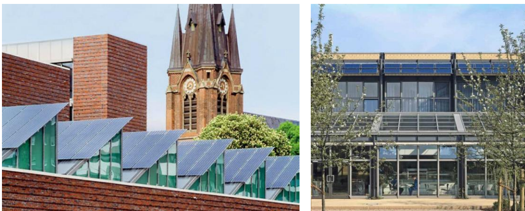
Abb. 109: Optische Hervorhebung von PV-Anlagen durch Komplementärfarben: Museum für Archäologie, Herne (links: Krippner 2016, S. 121); ehemaliges HEW-Schulungszentrum, Hamburg (rechts: Denkmalverein/Fotografie Dorf Müller Klier)
