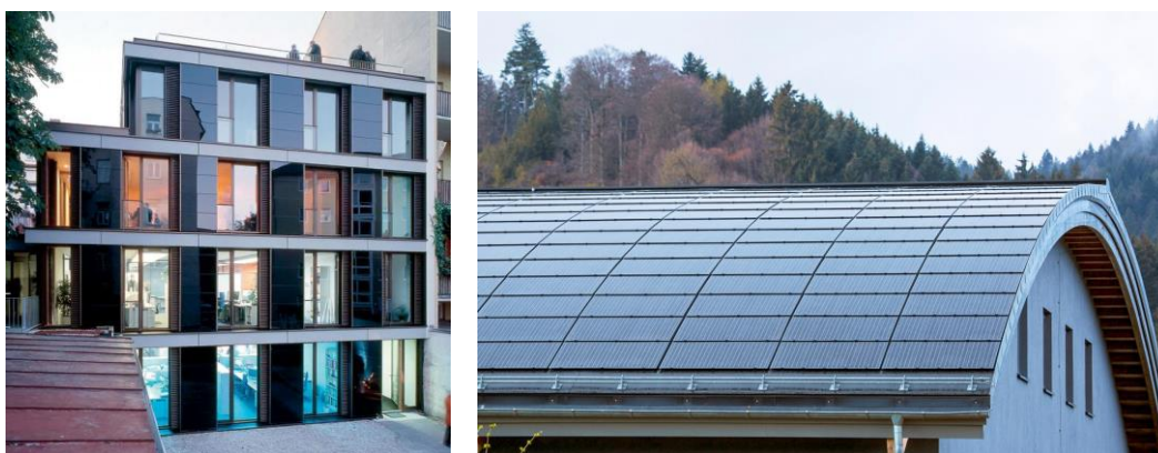
Abb. 103: Maßstäblich ausgewogene Einfügung einer PV-Anlage, durch Ähnlichkeit in der Größe: Bürogebäude Blütenburgstraße 44 in München (links: a+p Architekten); Mehrzweckhalle in Preisegg (rechts: Müller Polybau AG)
