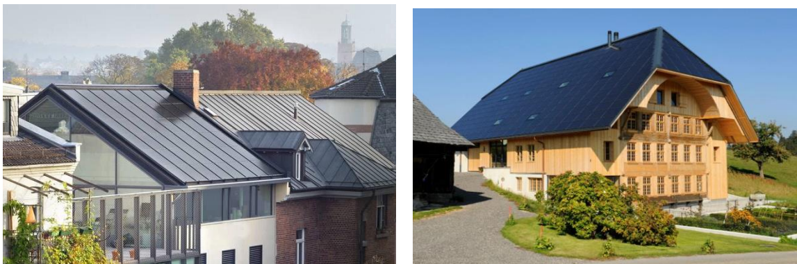
Abb. 115: Vollständig unauffällig eingefügte PV-Dächer durch farbliche und materielle Anpassung am opusHouse, Darmstadt (SeV 2009, S. 6) und durch regionaltypische formale Ausgestaltung am Glaserhaus im Emmental (CH) (rechts: Baunetz Wissen/Cleverage)
