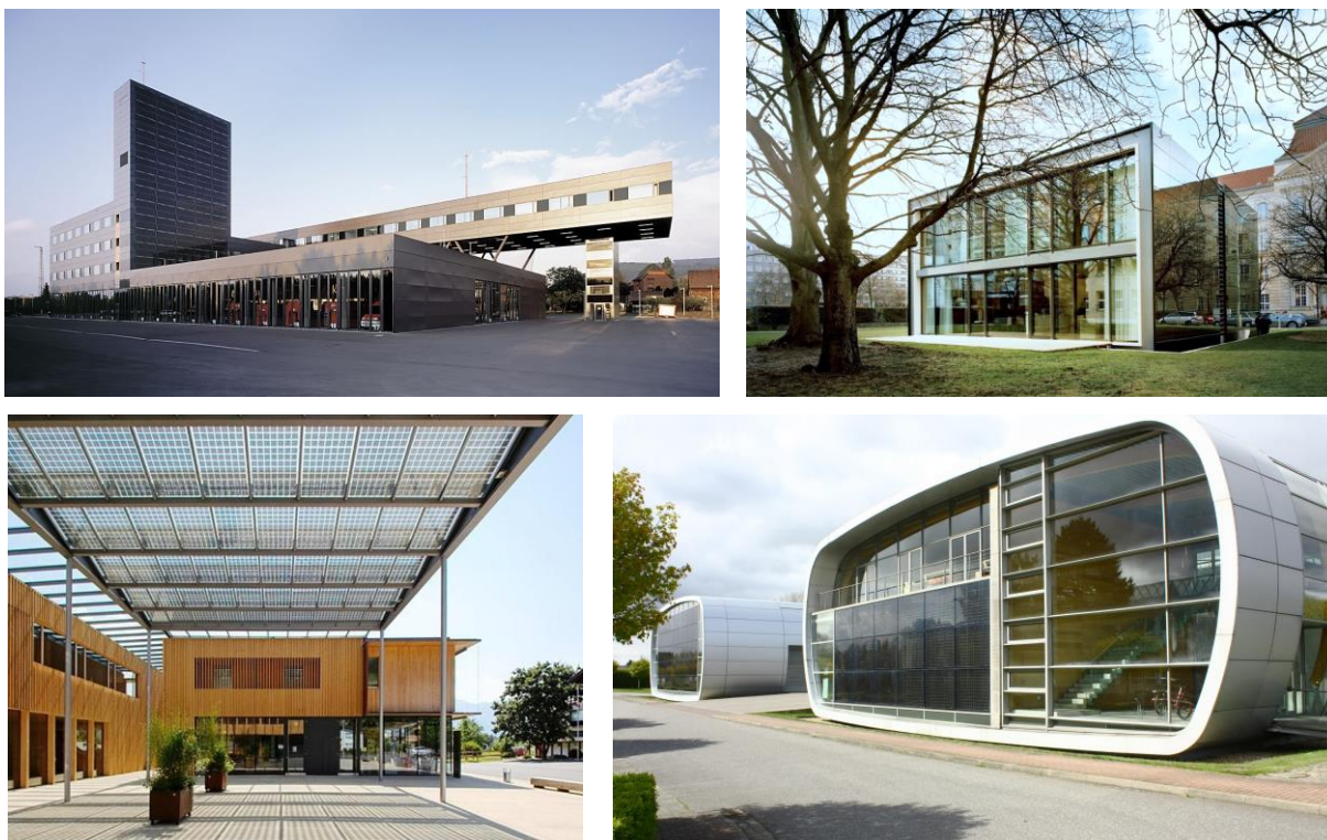
Abb. 94: Projektbeispiele mit einer ausgewogen integrierten PV-Anlage, die sich harmonisch und dennoch erkennbar in das Gebäude und die Umgebung einfügt (v. o. l. n. u. r.): Feuerwache, Heidelberg (Bauwelt/Lukas Roth); Effizienzhaus Plus, Berlin (DBZ/Matthias Koslik); Gemeindeamt Ludesch (BauNetz Wissen/Bruno Klomfar); Tobias Grau GmbH, Hamburg (eigene Aufnahme)
