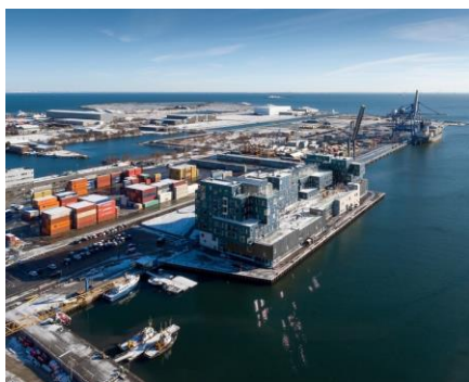
Abb. 10.15: Luftaufnahme aus Südwest
