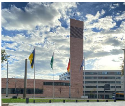
Abb. 13.17: Das Gebäude in seiner Nachbarschaft, Blick von Norden
