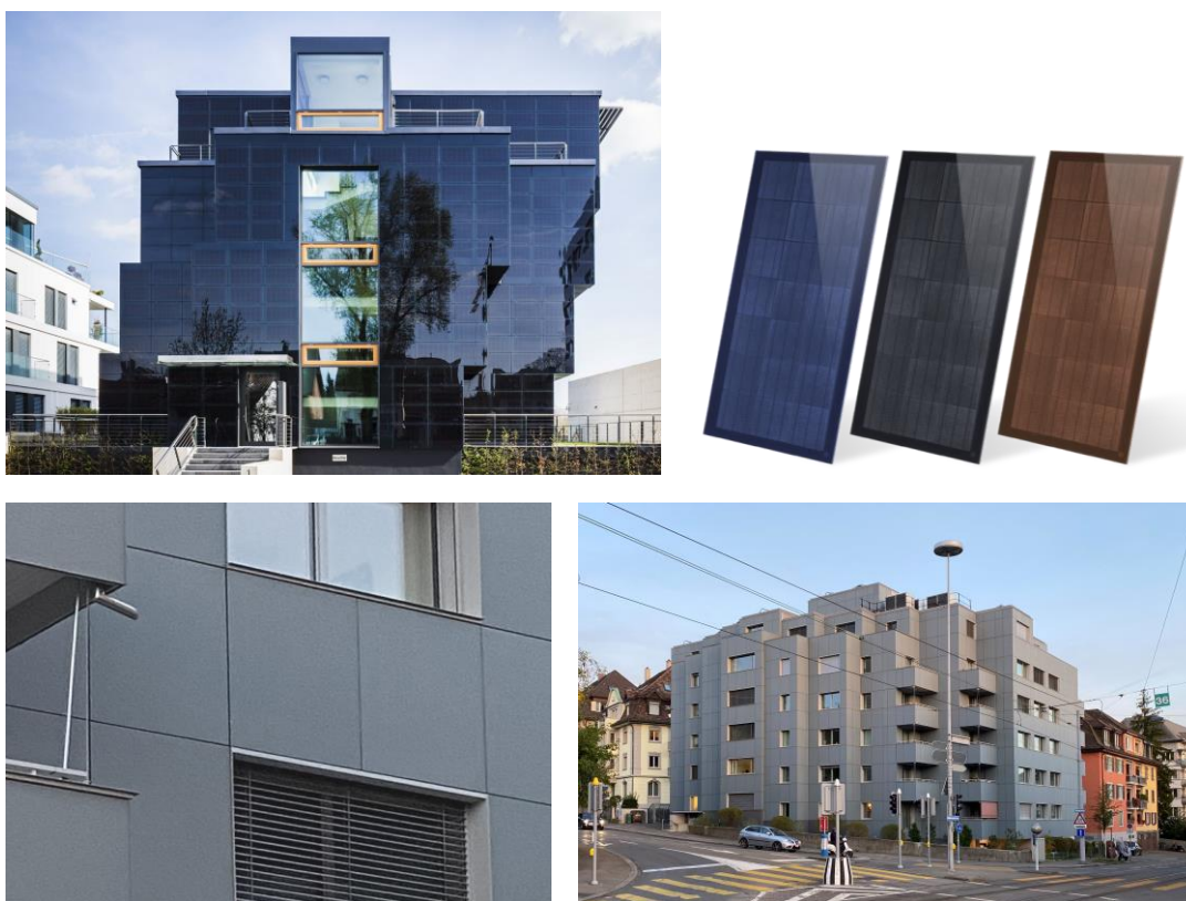
Abb. 77: Die farbliche Erscheinung von Solarmodulen, an unterschiedlichen Positionen im Modul beeinflusst: auf Hintergrundgläsern am Firmengebäude der WetterOnline GmbH in Bonn (oben: Sunovation) und an der Rückseite von Deckgläsern am Mehrfamilienhaus Hofwiesen-/Rothstraße in Zürich (unten: eigene Aufnahmen)
