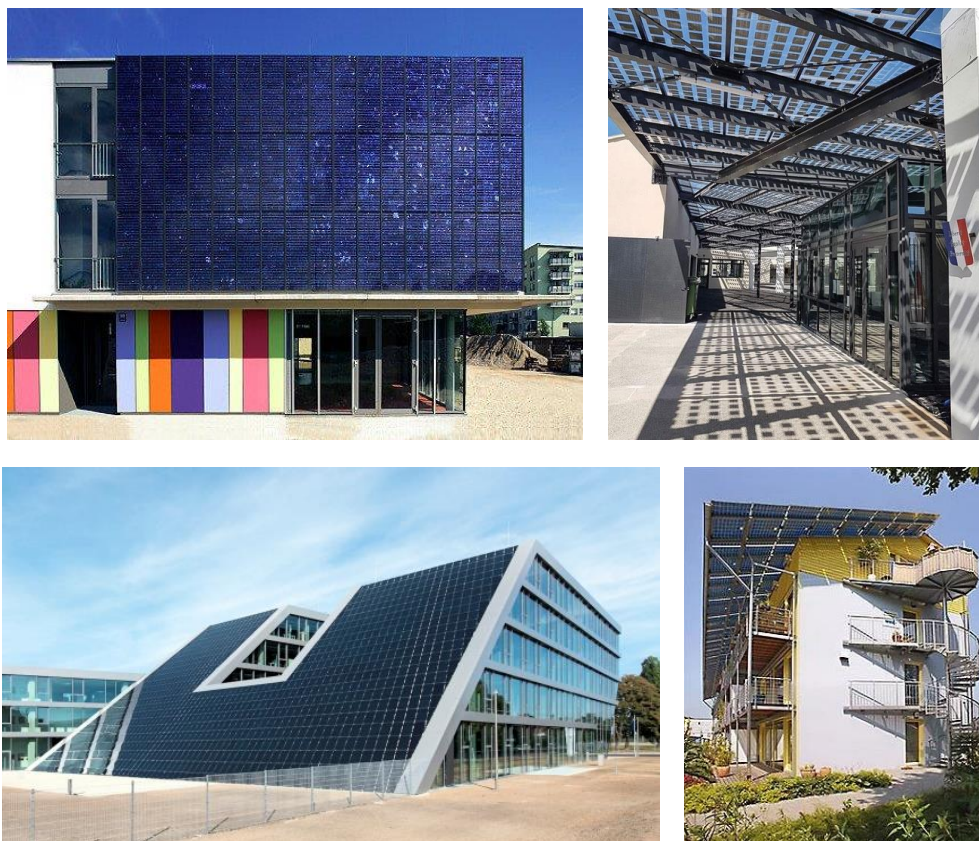
Abb. 96: Projektbeispiele mit prägnant-auffällig integrierten PV-Anlagen, die in ihrer Umgebung dominant und hervorgehoben erscheinen (v. o. l. n. u. r.): Kinderkrippe und Jugendfreizeitstätte, München (Baunetz Wissen); Collège de la Nativité, Aix-en-Provence (Sonnenstromfabrik); Neubau der Hahn+Kolb Gruppe in Ludwigsburg (Hahn+Kolb/David Franck); Solarsiedlung am Schlierberg, Freiburg (Baunetz Wissen)
