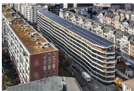
Abb. 9.9: Gesamtansicht der Generatorflächen in Dach und Fassade
