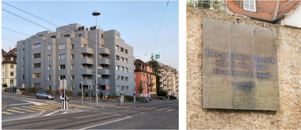
Abb. 118: Unauffällige Einfügung von optisch stark an Materialien der Umgebung angelehnte Generatoren ohne jegliche PV-typische Zeichenwirkung: Fassade des Mehrfamilienhauses Hofwiesen-/Rothstraße, Zürich (links: eigene Aufnahme); PV-Module mit Schiller-Zitat an der Stadtmauer in Marbach (rechts: Alamy Stock)
