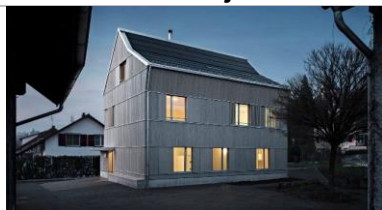
Abb. 131: Wohnhaus Glattfelden (Mirlo Urbano Architekten)
