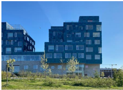
Abb. 10.9: Ansicht von Norden
