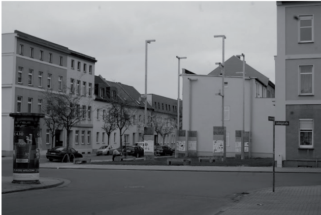
Abb. 14: Baulücke nach dem Abriss eines markanten Eckgebäudes in einem Altbauquartier in Köthen
