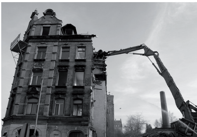
Abb. 12: Abriss in einem Gründerzeitquartier in Chemnitz
