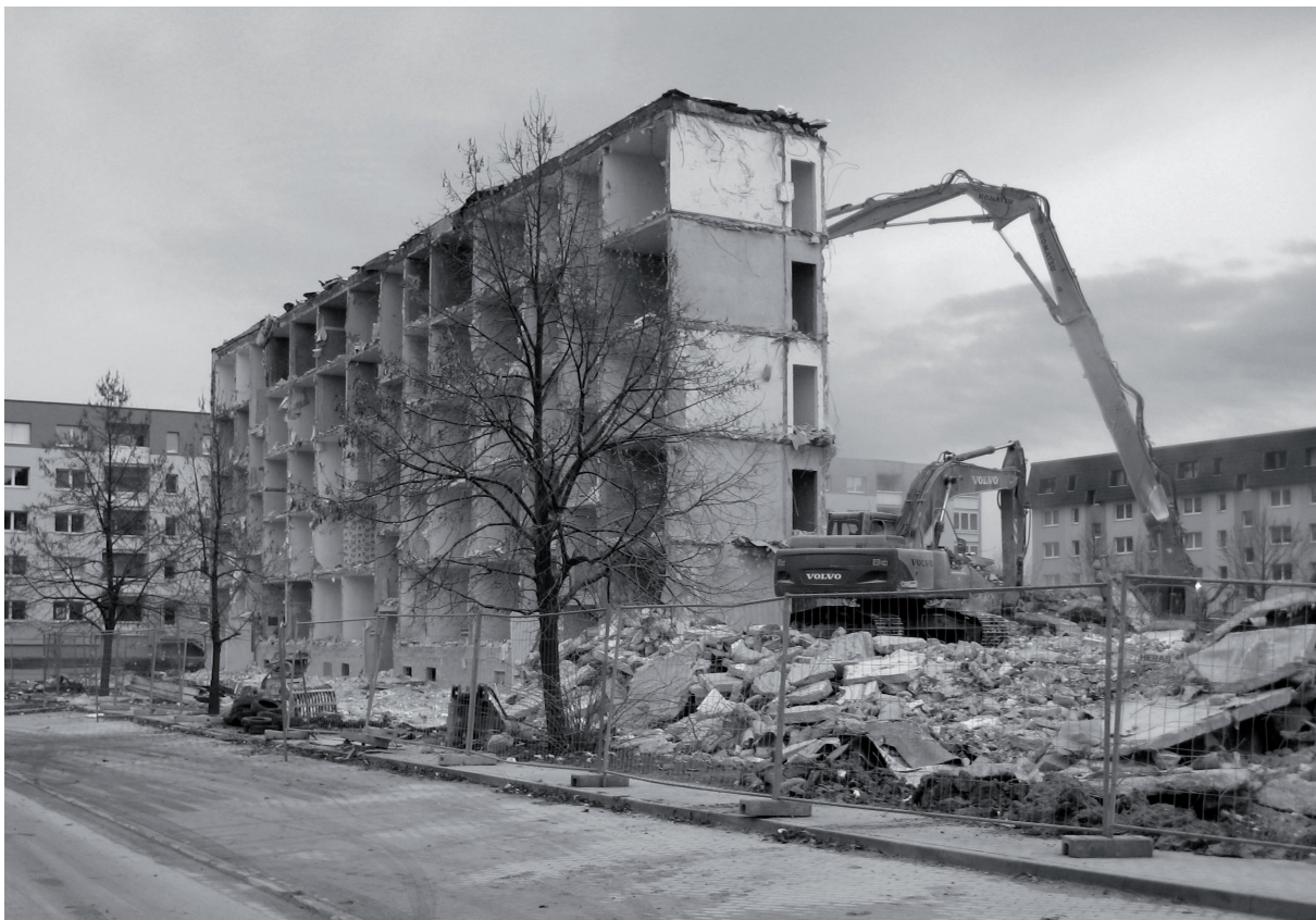
Abb. 1: Abriss eines Plattenbaus aus den achtziger Jahren in Köthen
