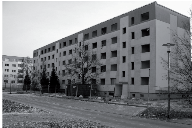
Abb. 30: Plattenbau aus den achtziger Jahren kurz vor dem Abriss (2. Rückbauphase)
