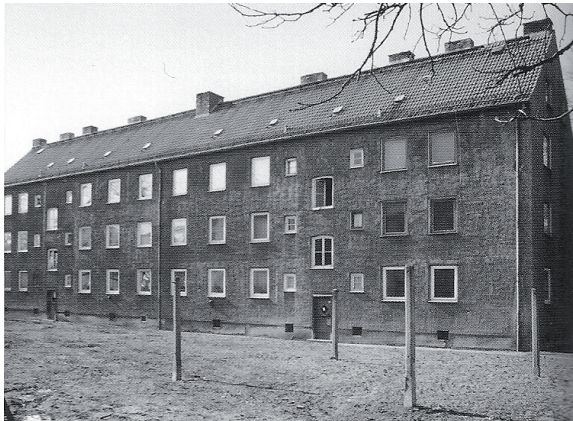
Abb. 29: Abgerissener Werksiedlungsbau der dreißiger Jahre (1. Rückbauphase)
