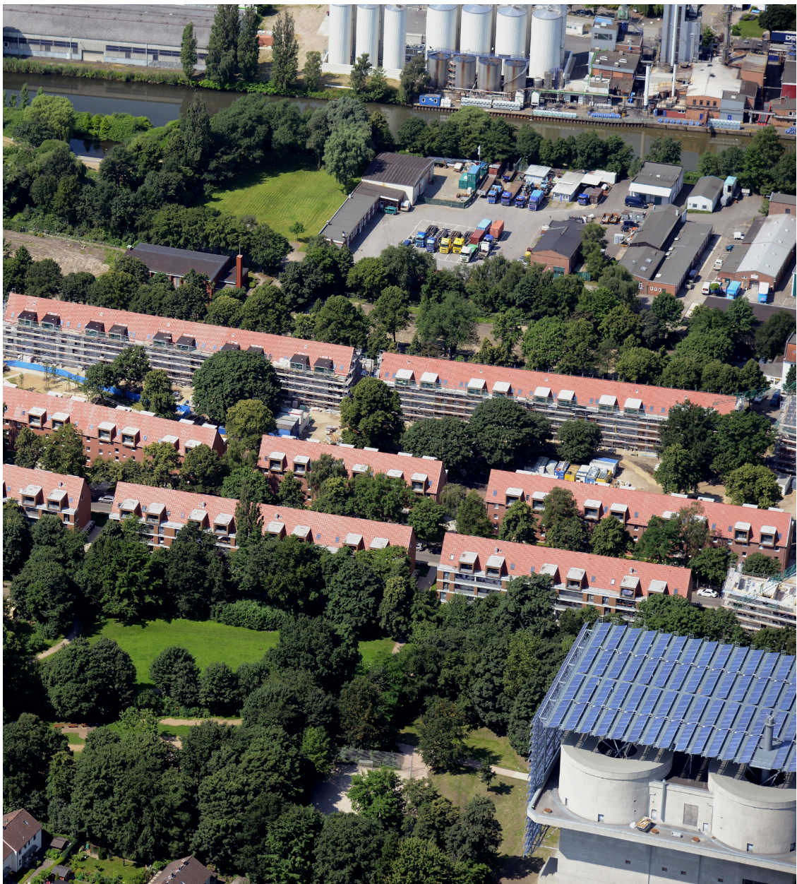
Abb 4: Der Energiebunker in Hamburg-Wilhelmsburg versorgt das umliegende Wohnquartier im Rahmen eines Nahwärmenetzes (IBA Hamburg GmbH; Friedel o.J.)
