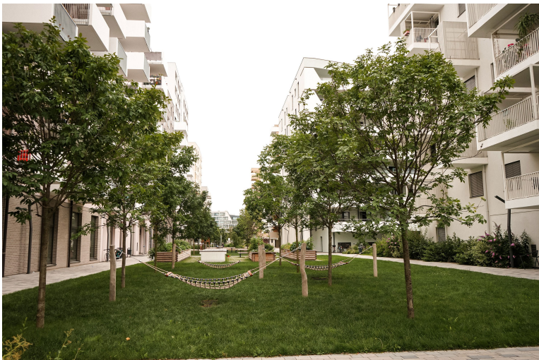
Rückseite und Innenhöfe der Wohnbauten an der Bruno-Marek-Allee
