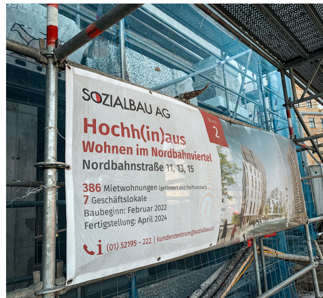
Wohnbauten im Bau entlang der Nordbahnstraße
