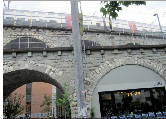
ABB. 50: VIADUKTBÖGEN IN ZÜRICH II
