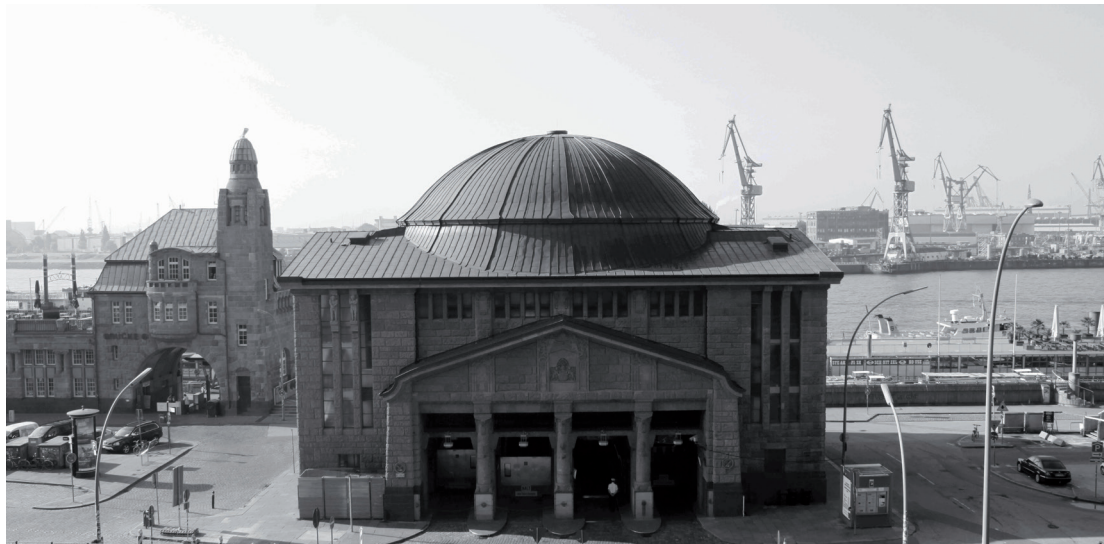
ABB. 9: DAS EINGANGSGEBÄUDE DES ALTEN ELBTUNNELS AM NORDELBUFFER
