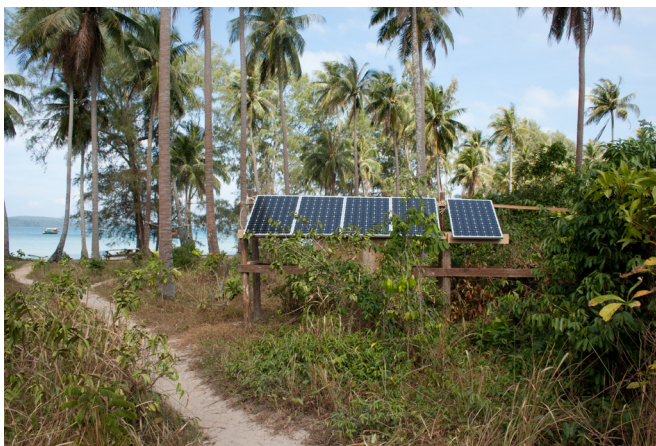
Abb. 55 Photovoltaik-Anlage
