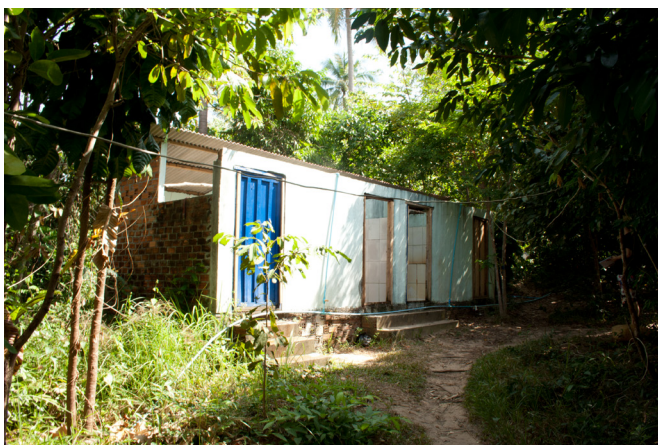
Abb. 23 Duschen/WCs (Bild 3) Mauerwerk, 4 Kabinen mit WC, Dusche und Wassertank
