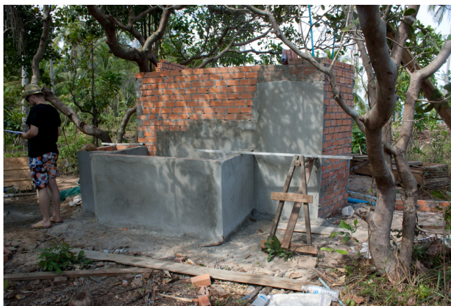
Abb. 51 Neubau Duschhaus, Wassertank
