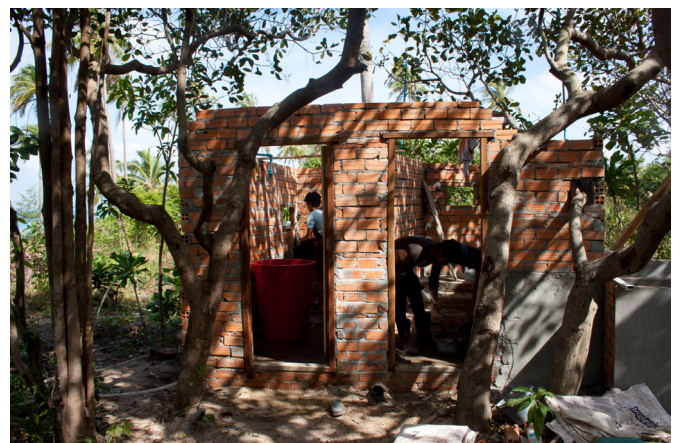
Abb. 20 Sanitäreanlage für Birdsnests (Bild 2) im Bau, zwei Duschen
