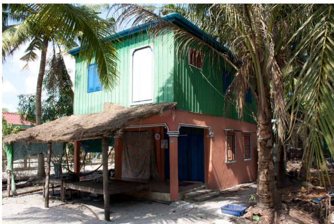
Abb. 36 Einzelhaus mit gemauertem Sockelgeschoss in Preaek Svay, Koh Rong
