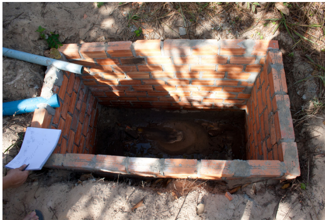
Abb. 50 Neubau Duschhaus, Sickergrube
